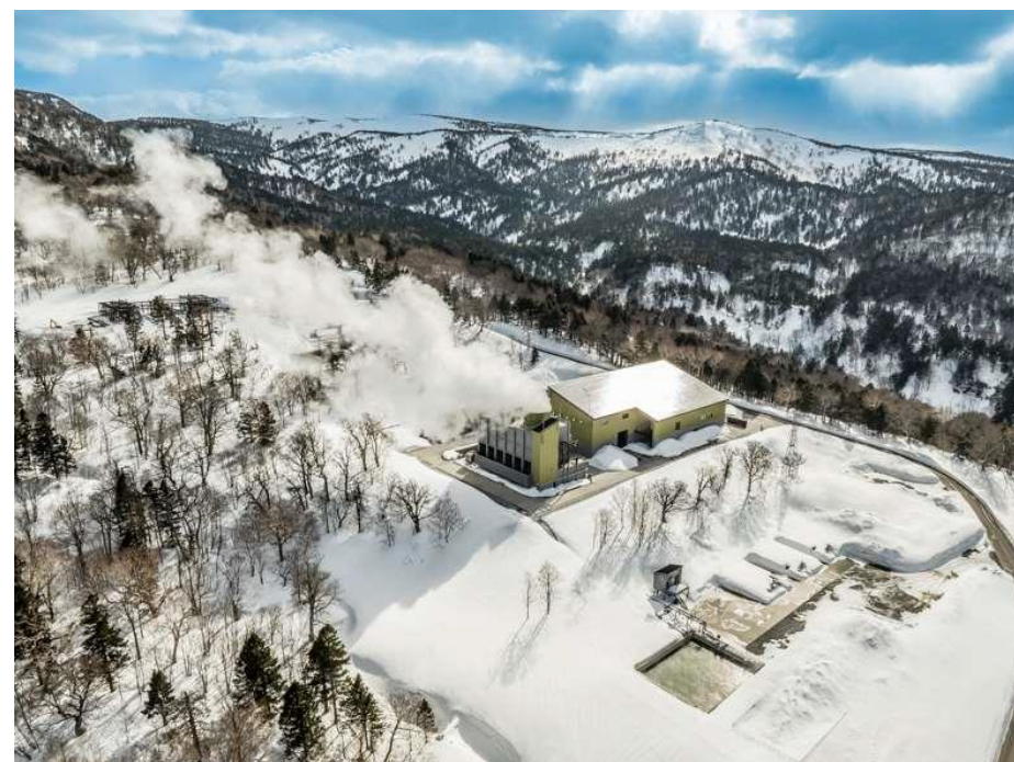
冬の安比地熱発電所
