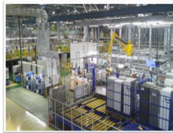
家電リサイクル 冷蔵庫処理ライン
