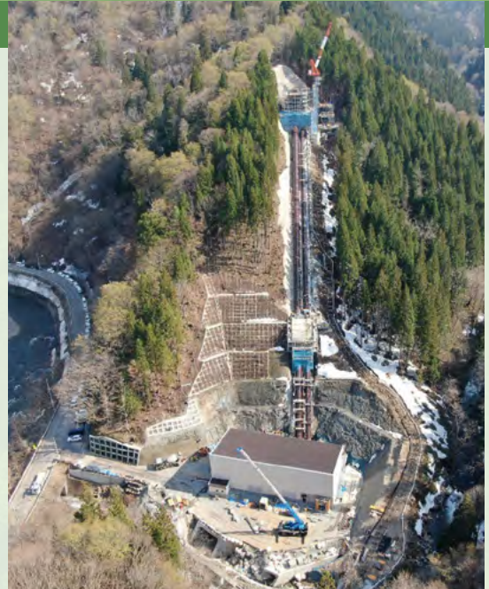
小又川新発電所 発電所エリア(第三工区)全景
