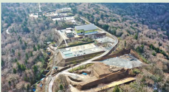
安比地熱発電所 (建設中)
