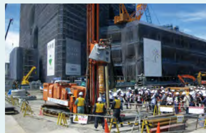
地中熱利用システム 工事の様子(東京スカイツリー)
