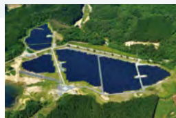
▲ 入釜太陽光発電所
