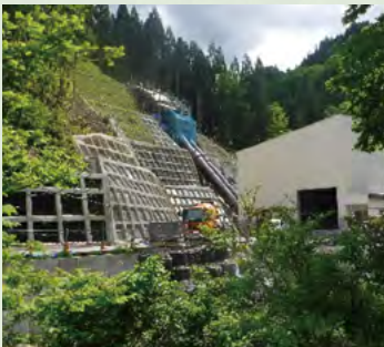
小又川新発電所 建屋建築状況
