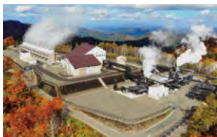
山葵沢地熱発電所
