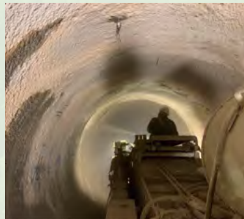
小又川新発電所 第二工区吹付状況
