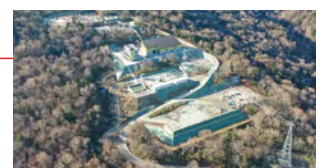
安比地熱発電所(建設工事全景)
