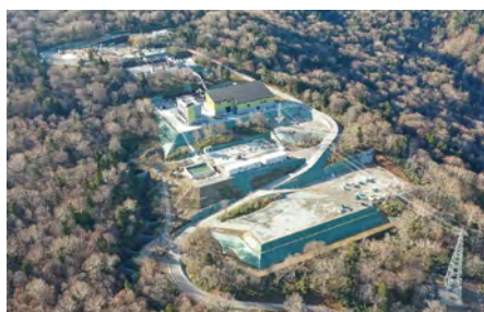
安比地熱発電所(建設工事全景)
