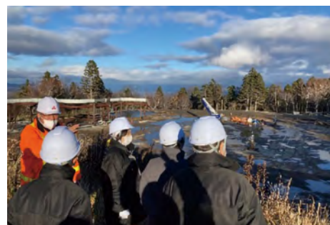
安比地熱発電所建設現場(岩手県)の視察
