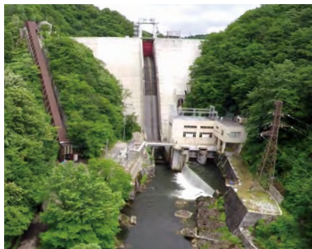
小又川第四発電所
