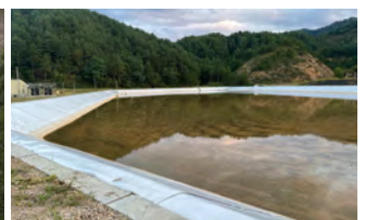
貯水槽（尾去沢鉱山）
