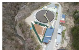
坑廃水処理施設（八谷鉱山）
