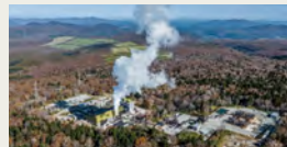
安比地熱発電所全景
