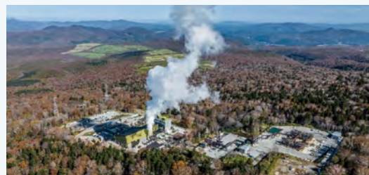
安比地熱発電所全景
