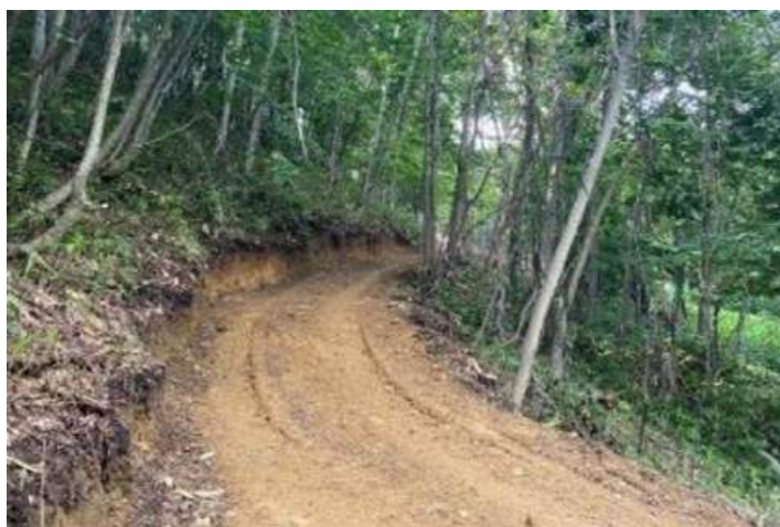
小規模幅員の作業道
