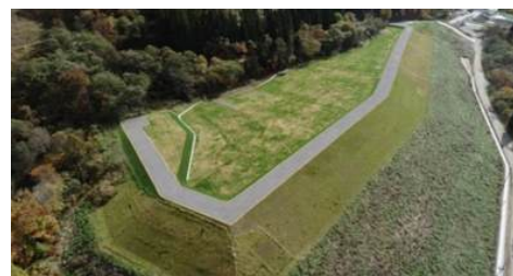
八谷鉱山集積場安定化工事（完工後）
