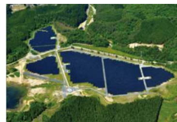
入釜太陽光発電所（宮城県） 事業主体：エルエムサンパワー（株） 2015年1月運転開始 出力：6,930kW
