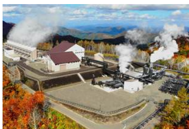
山葵沢地熱発電所（秋田県） 事業主体：湯沢地熱（株） 2019年5月運転開始 出力：46,199kW
