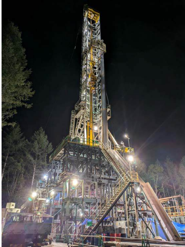
掘削調査の様子
