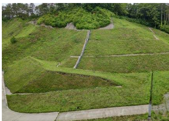
小真木鉱山 発生源対策工事 (上：施工前・下：施工後)
