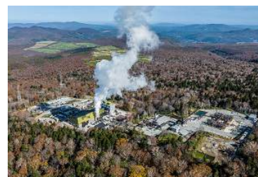
安比地熱発電所（岩手県） 事業主体：安比地熱（株） 2024年3月運転開始 出力：14,900kW
