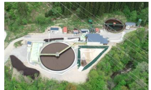
坑廃水処理施設（八谷鉱山）
