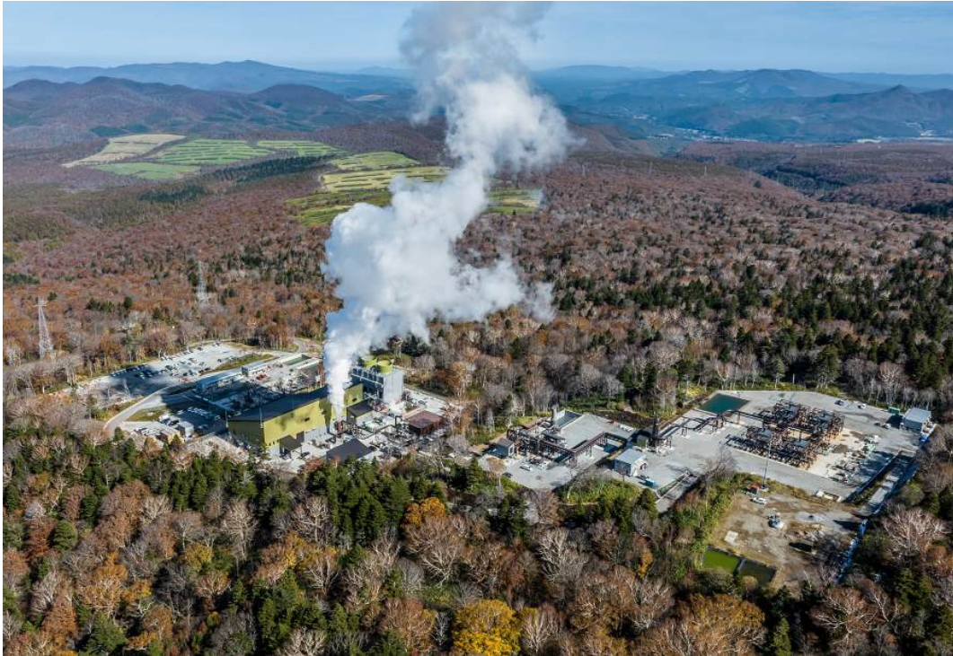
安比地熱発電所全景
