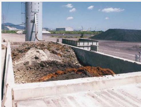
建設汚泥・残土受入れ
