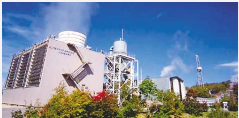
大沼地熱発電所
