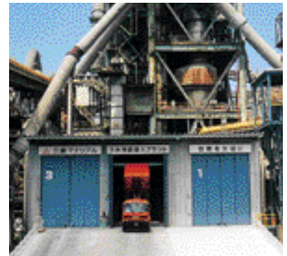
九州工場下水汚泥受入設備
