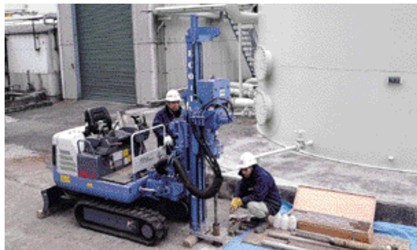
総研の敷地内ボーリング調査
