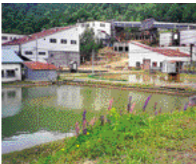
下川鉱山坑廃水処理設備 (北海道下川町)
