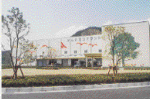
地域共生型環境事業・福岡県 福岡市の一般ごみ 固形燃料化施設、固型燃料は隣接する当社九州 工場 (セメント生産) で処理
