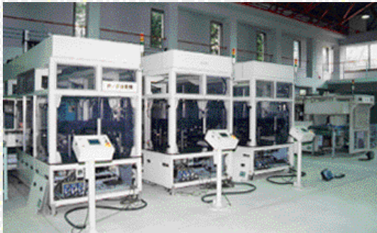
家電リサイクル事業用TVリサイクル プロセスデモンストレーションプラント (宮城県鶯沢町)
