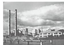
三菱セメント(株)黒崎工場 (現九州工場黒崎製造課)
