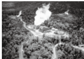
澄川地熱発電所
