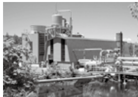
大沼地熱発電所
