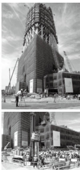
東京スカイツリー地中熱交換井設置工事状況
