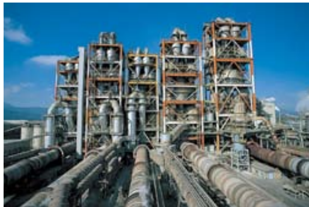
九州工場 キルンとサスペンションプレヒーター
