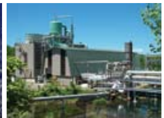
大沼地熱発電所
