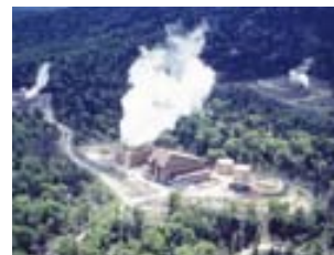
澄川地熱発電所
