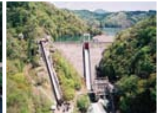
小又川第四発電所（水力）
