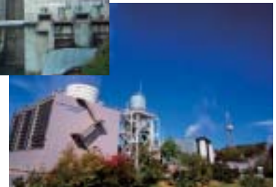
大沼地熱発電所
