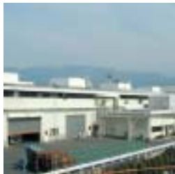
アルミ缶リサイクル工場 三菱アルミニウム(株) 富士製作所ほか
