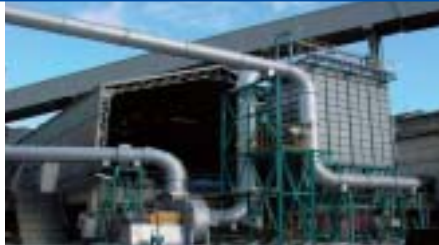
塩素パイパス
