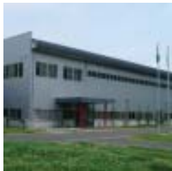
家電リサイクルプラント 東日本リサイクルシステムズ(株) ほか5工場
