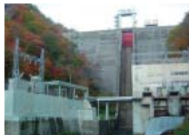
小又川第四水力発電所
