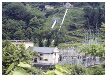
小又川第一水力発電所(秋田県)
