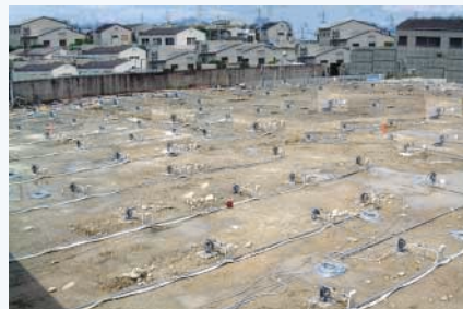
土壌地下水浄化工事(mrc方式高密度井戸設置工法)
