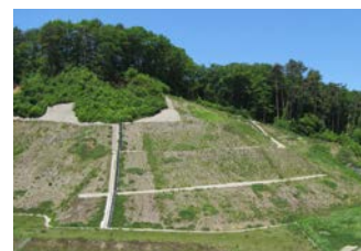
小真木鉱山発生源対策工事(チップクリート)
