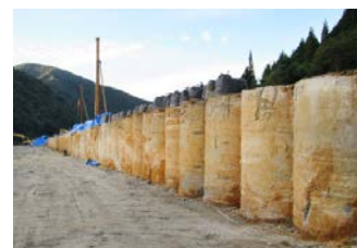
八谷鉱山集積場安定化工事(地盤改良)
