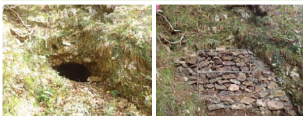
坑口閉塞工事(左:施工前、右:施工中)(佐渡鉱山)
