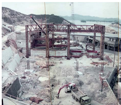
建設中の三菱連続製銅炉(1973年)
