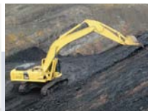
北菱産業埠頭(株) 石炭露天採掘坑(北海道美瑛市)
