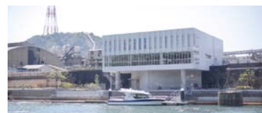
耐震性を向上させた直島製錬所厚生棟
