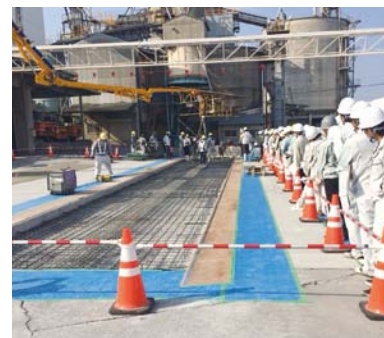
中国菱光(株)での施工現場
