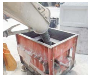
コンクリートブロック製造の様子
