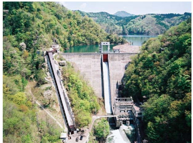
小又川第四水力発電所(秋田県)
