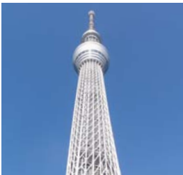
ボアホール方式を施工した東京スカイツリー
