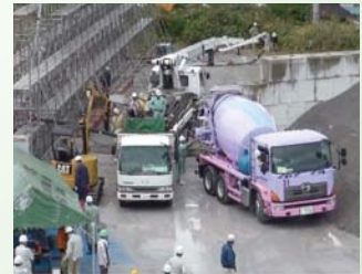
CUS2.5細骨材コンクリートの圧縮性確認試験
