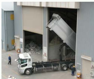
岩手工場廃棄物受入施設
