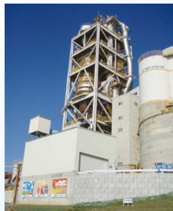
青森工場廃棄物受入施設(手前建屋)
