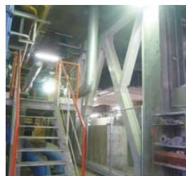
耐震補強した建屋
