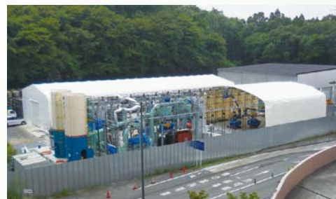
いわき市南部清掃センター内に建設中のセメント固型化施設
