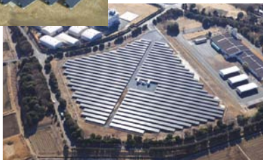
真壁太陽光発電所 (茨城県桜川市)
