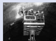
（株）ダイヤモンドコンサルタント トンネルの点検・調査
