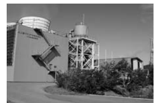
大沼地熱発電所
