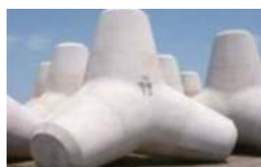
銅スラグが使用された重量コンクリートの消波ブロック
