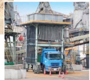
クレーンによる船からトラックへの積み込み
