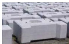
ケーソンの中詰め材として活用
