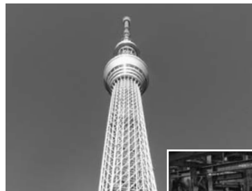
ボアホール方式を施工した東京スカイツリー
