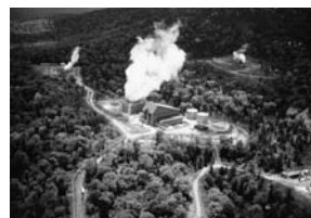
澄川地熱発電所
