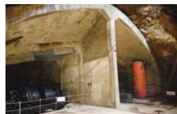
巻揚げ室内部
