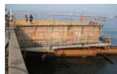
直島製錬所でのバース拡張工事に使用
