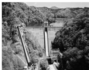
小又第四水力発電所
