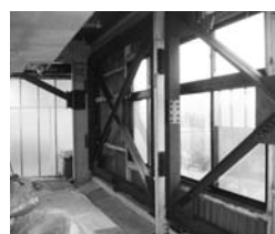
耐震補強工事
