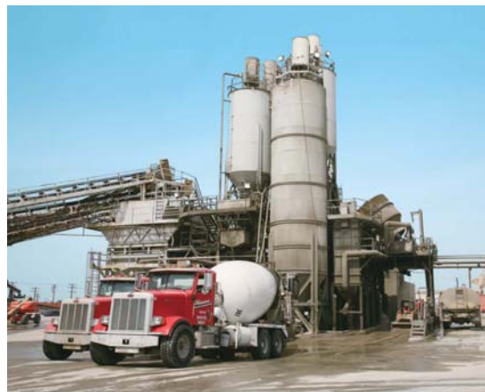
RRM社 生コンクリート工場
