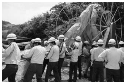
オイルフェンスの繰り出し作業
