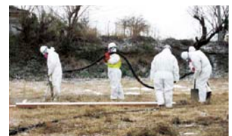
超微粒子セメントによる汚染土壌の固型化
