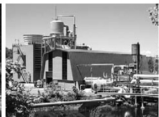
大沼地熱発電所
