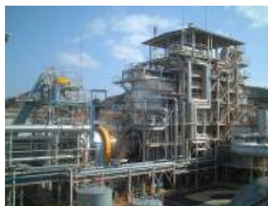
直島製錬所のリサイクルプラント
