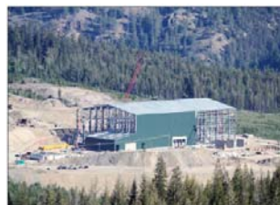
選鉱場建屋建設工事
