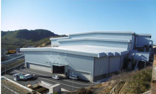
直島製錬所第2金銀滓センター建屋外観
