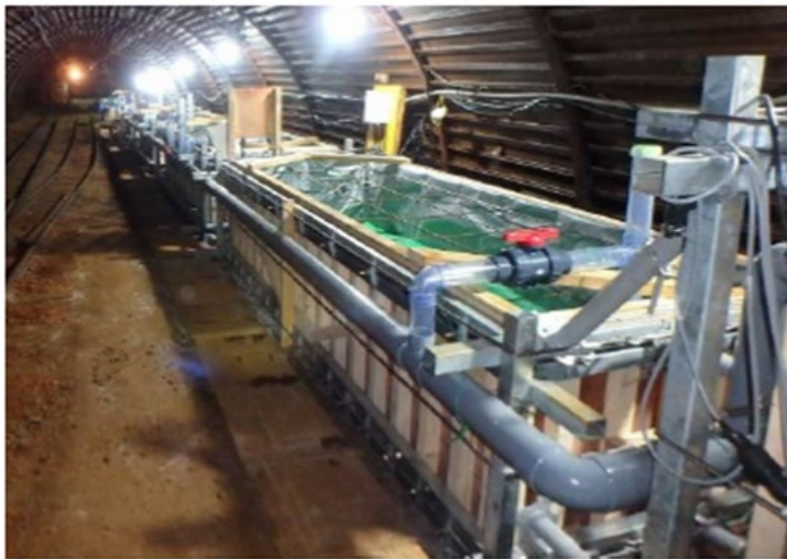
吸着処理 現地試験
