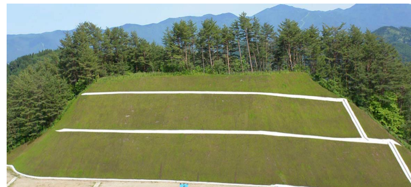
発生源対策工事
