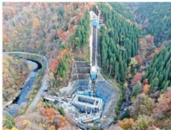
小又川新水力発電所（秋田県、建設中）
