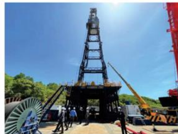
掘削調査の様子
